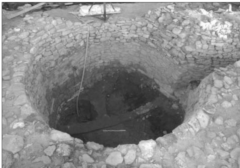
Figura 3. El fossat assegura la recàrrega del pou cisterna situat al bell mig del recinte fortificat. El baixador permetia assolir la cota més habitual d'aigua i devia facilitar les tasques de neteja i manteniment
